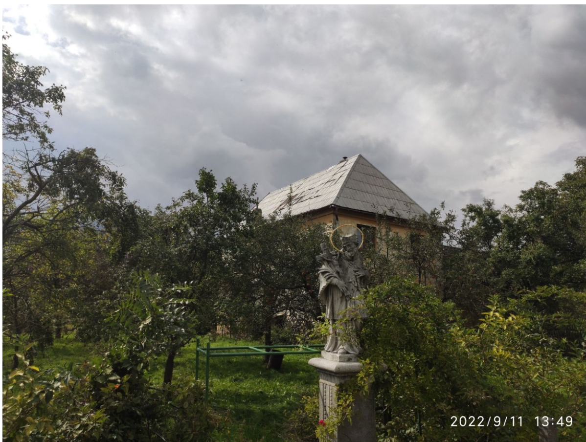
Obr. 8: Poškozená plechová střecha (již částečně opravena). Foto: Matěj Grék.
